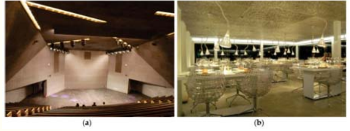
ध्वनि नियंत्रण के लिए एल्यूमिनम फोम द्वारा कवर किया गया (a) दर्शक हॉल की छत; और (b) रेस्तरां
